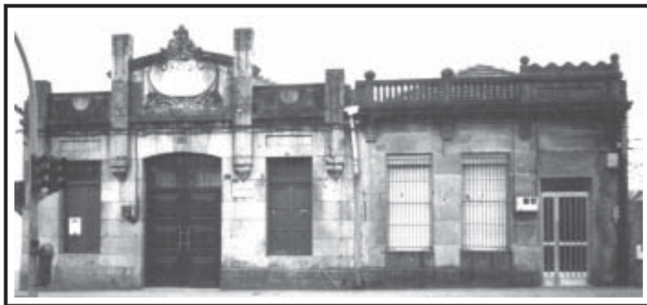
Edificio de la antigua Sociedad de Agricultores de Lavadores, en la Avenida Ramón Nieto 58. Hoy pertenece a la Asociación de Vecinos de O Calvario
